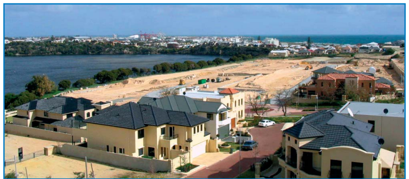
New Subdivision Works
